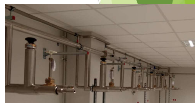
Instalacja VIP ciekłego azotu - Biobank
