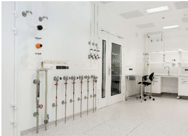
Instalacje gazów ultraczystych - CEZAMAT
